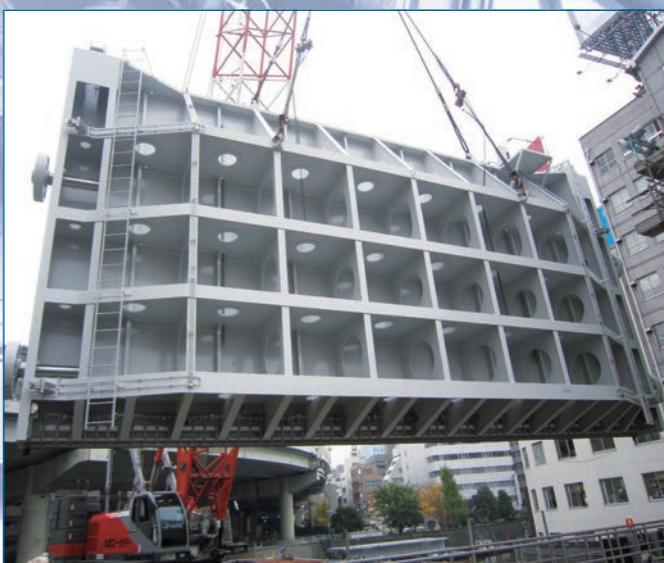
事前調査し現地搬入後、戸当金物据付、扉体現地組立後 吊込み、開閉装置の設置を行います。
