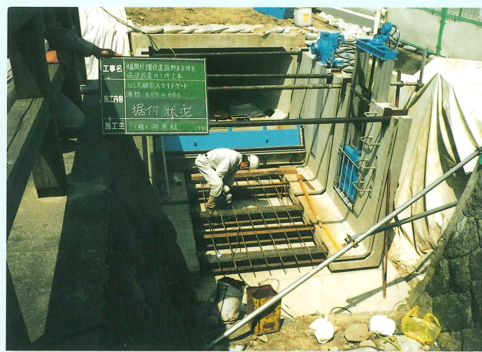
(据付調整・ブロック補強)
