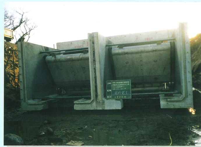
(現場施工完成)
