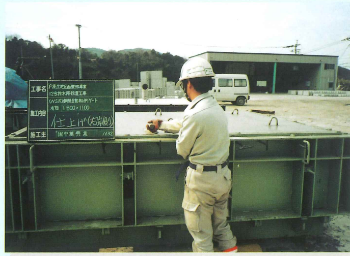
（コンクリート仕上げ）
