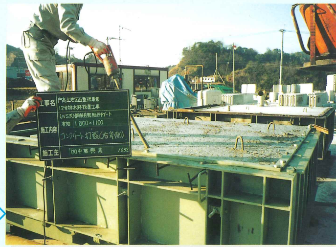
（コンクリート打設）
